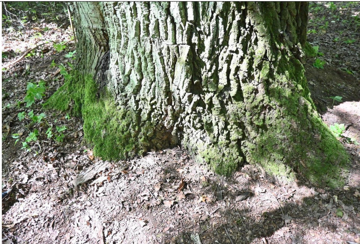
Zdj. 7. Miejsce niewielkiego uszkodzenia odziomka pomiędzy nabiegami korzeniowymi
