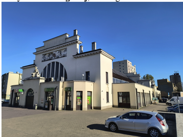
Zdjęcie nr 20. Budynek hali targowej, ul. Targowa 1
