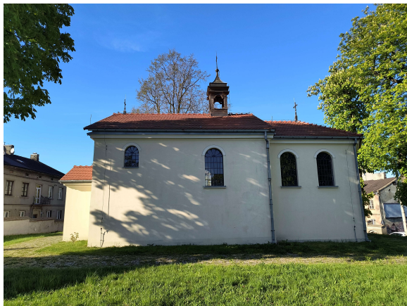
Zdjęcia nr 11. Kościół pw. Nawiedzenia Najświętszej Marii Panny, ul. Krakowskie Przedmieście 31/33
