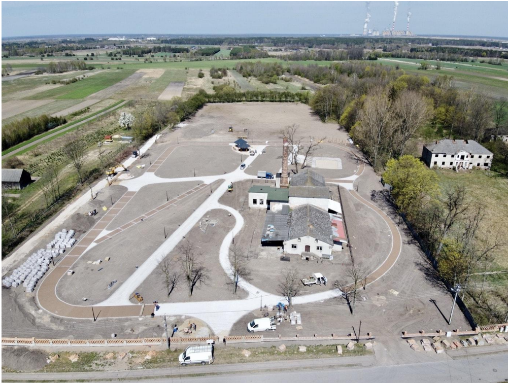
Chorzenice – park w trakcie rewitalizacji (źródło: strona www.chorzenice/twojepajeczno.pl )
