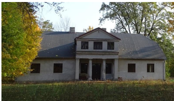
Fotografia 8. Widok na dwór w Kalinowej.
