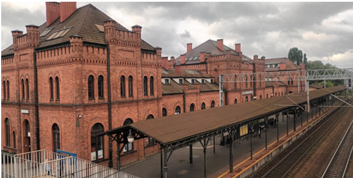
Dworzec kolejowy z wiatą peronową, źródło: radiolodz.pl
