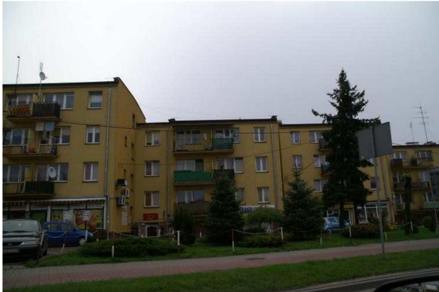
Fot. Osiedla mieszkaniowe posiadają podstawową warstwę izolacyjną. W większości przypadków wymienione zostały okna na PCV.
