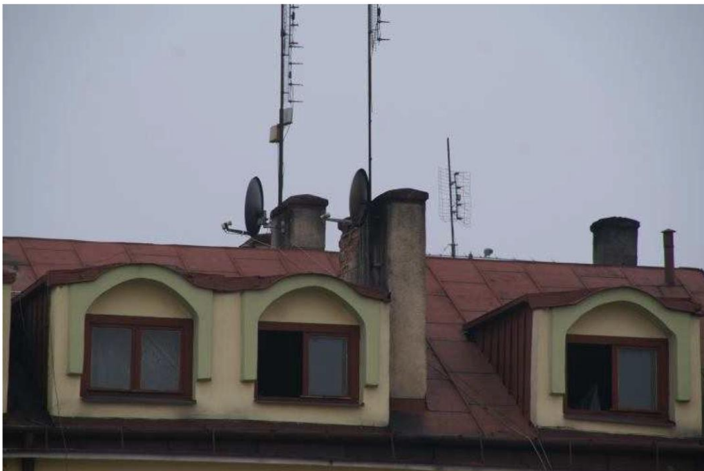
Fot. Nawet w centrum Miasta budynki zasilane są węglem
