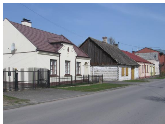
Zabudowa ul. Wyszyńskiego
