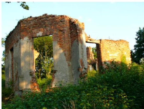
Fot. 15. Ruiny pałacu w Górze
