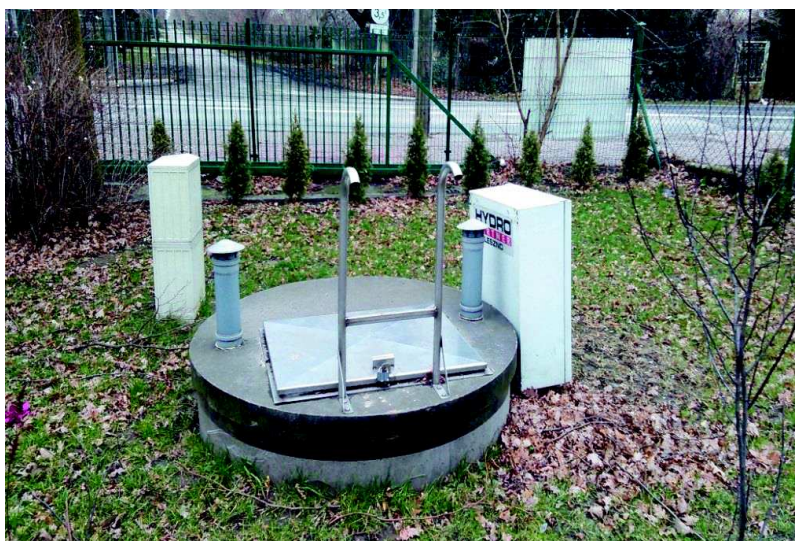
Rozbudowa systemu kanalizacji sanitarnej i wodociągowej w Gminie Ożarów Mazowiecki - etap I
