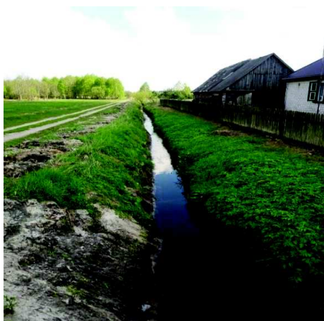
Odbudowa rowów melioracyjnych na terenie gminy Mrozy
