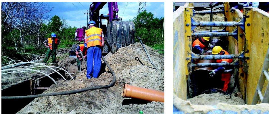
Rozbudowa sieci wodociągowej i kanalizacji sanitarnej na terenie Józefowa
