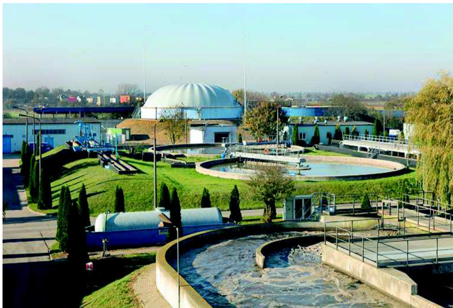
Rozbudowa oczyszczalni ścieków w Płońsku (przebudowa gospodarki osadowej)
