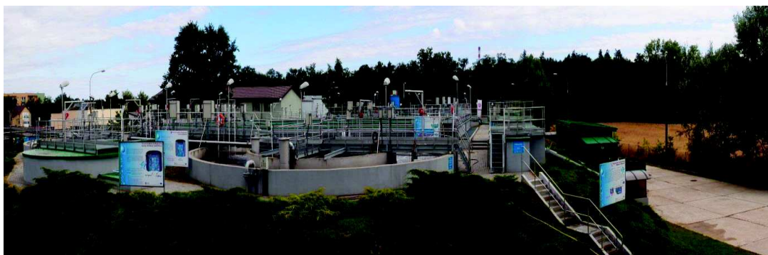
Modernizacja oczyszczalni ścieków wraz z budową sieci kanalizacyjnej i wodociągowej w Nowym Dworze Mazowieckim
