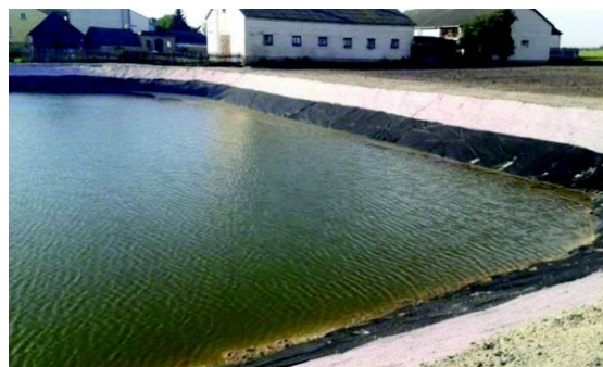
Budowa zbiornika wodnego w miejscowości Rzeszotków, gmina Paprotnia
