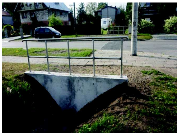
Modernizacja rowu melioracyjno-komunalnego w mieście Marki
