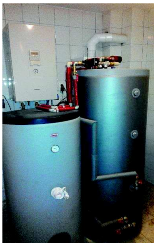
Zakup i montaż pompy ciepła w domu mieszkalnym na terenie gminy Radziejowice
