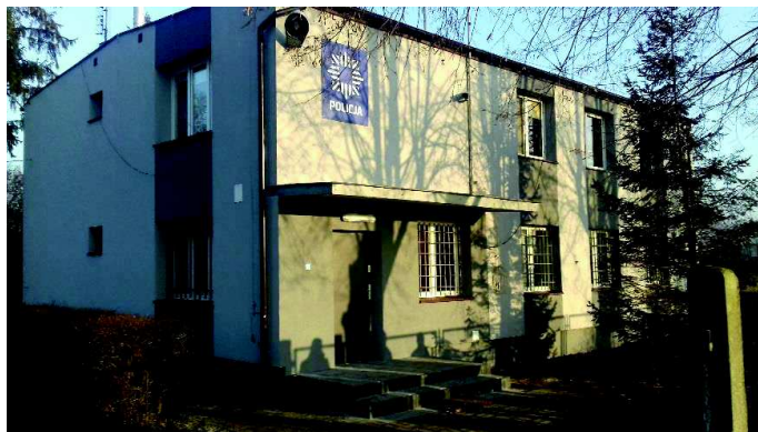
Termomodernizacja budynku Posterunku Policji w Łącku
