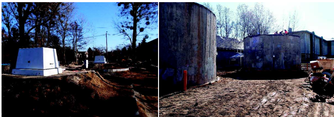
Modernizacja i rozbudowa systemu infrastruktury wodociągowo-kanalizacyjnej gminy Milanówek
