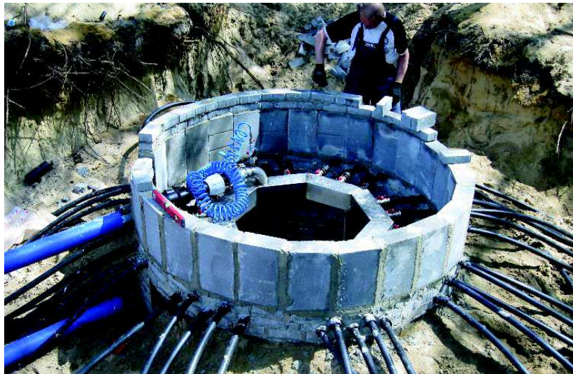
Instalacja gruntowej pompy ciepła o mocy 160 kW na terenie gminy Wilga
