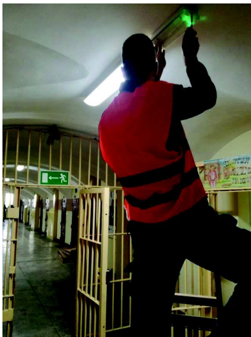
Wymiana wewnętrznych opraw oświetleniowych wraz ze źródłem oświetlenia pomieszczeń budynków penitencjarnych Zakładu Karnego w Siedlcach
