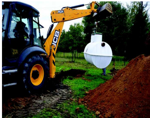
Budowa przydomowej oczyszczalni ścieków w miejscowości Izabela, gmina Wiązowna
