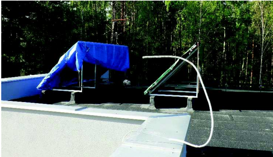
Zakup i montaż kolektorów słonecznych na terenie gminy Wyszaków
