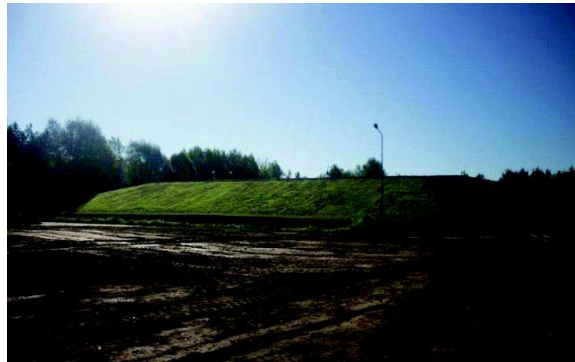
Składowisko odpadów po rekultywacji w gminie Łochów
