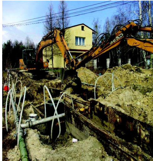
Budowa kanalizacji sanitarnej w miejscowości Hornówek, gmina Izabelin
