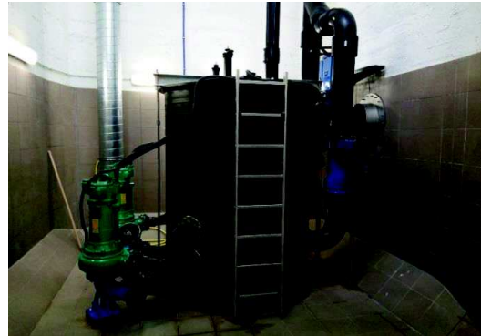
Przebudowa przepompowni ścieków w Wyszowie
