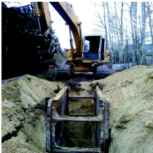
Budowa sieci kanalizacji sanitarnej na obszarze Aglomeracji Grodzisk Mazowiecki
