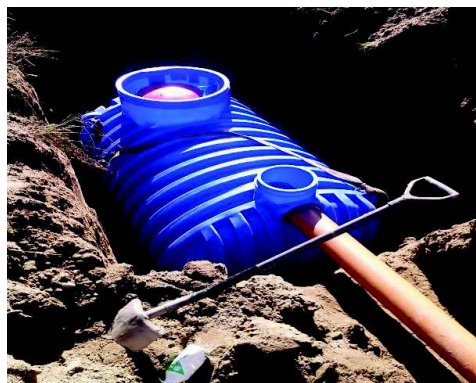
Budowa przydomowej oczyszczalni ścieków w miejscowości Dębe Wielkie, gmina Dębe Wielkie
