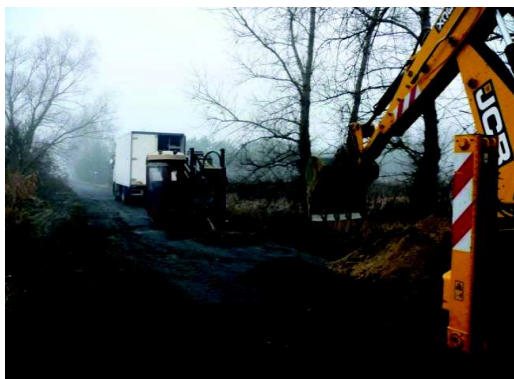
Budowa sieci wodociągowej w Kępie Kiełpińskiej, gmina Łomianki
