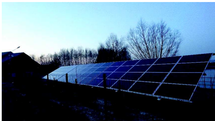
Zakup i montaż instalacji fotowoltaicznej na terenie gminy Wieliszew
