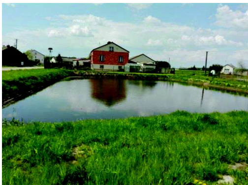
Wybudowany zbiornik wodny w miejscowości Koryciany, gmina Paprotnia
