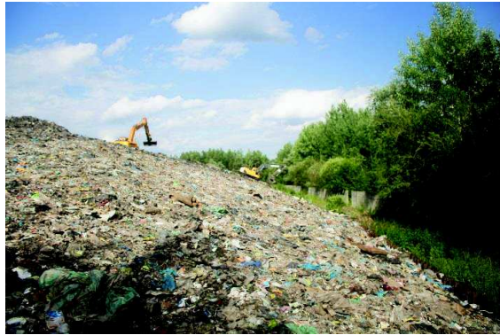
Składowisko odpadów przed rekultywacją w gminie Łochów
