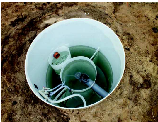
Budowa przydomowej oczyszczalni ścieków w miejscowości Suchodół, gmina Tarczyn
