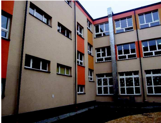
Termomodernizacja budynku Szkoły Podstawowej na terenie Miasta Pruszków
