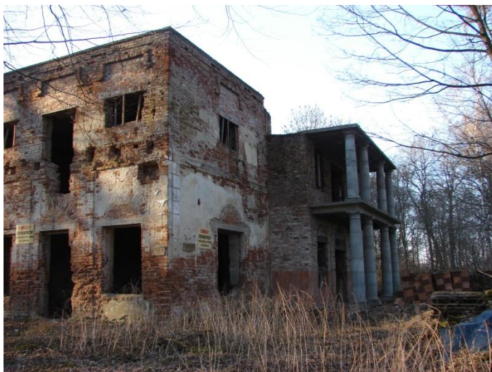
Dwór w Wólce Nosowskiej Kolonii (stan obecny)
