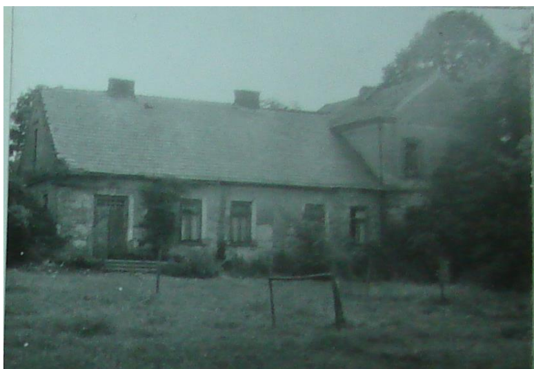
Dwór w Czeberakach przed remontem
