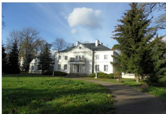
Fot. 13. Dwór w Pilaszkowie (archiwum własne)
