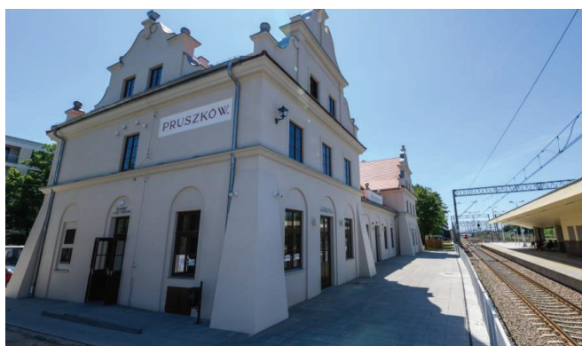
Fotografia 19. Widok na budynek dworca w Pruszkowie [10].
