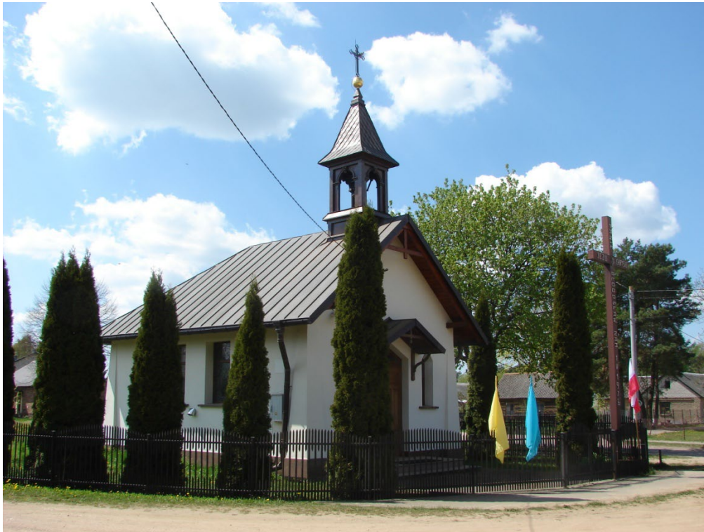
Kaplica w Wężach, stan na 2022 rok
