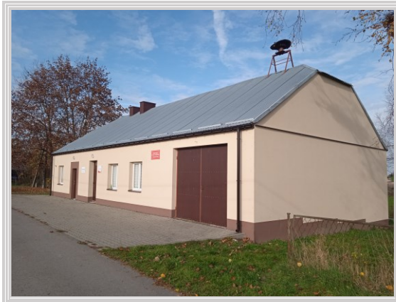
Budynek OSP w Zawadzie Starej
