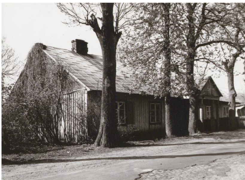
Rysunek 12 Nieistniejący budynek, Trojanów 64, d. budynek urzędu gminy, 1982 r.
