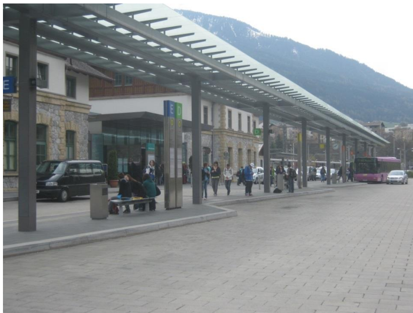
Rys. 12.2.2. Perony autobusowe przed dworcem kolejowym w miejscowości Landeck (Austria). Zaprojektowanie peronów w taki sposób ułatwia ich opuszczenie przez autobus.
