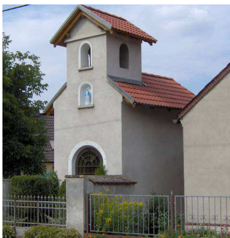
Żywocice, kaplica dzwonnica przy domu ul. Kozielska 19.
