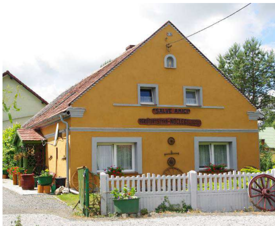
Pietna nr 10 - rok budowy 1886 - brak okapów.
