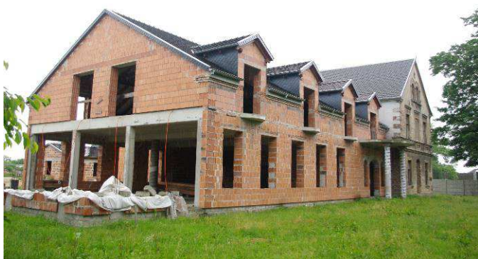
rozebrana i odtworzona współcześnie. Dwór w Żuzeli z części współczesną.
