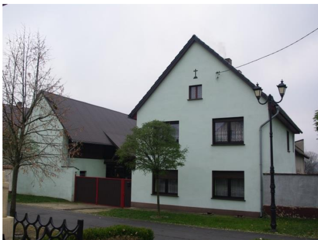
Budynek odnowiony, dobrze utrzymany, pozbawiony historycznego wystroju, z wysuniętymi okapami.
