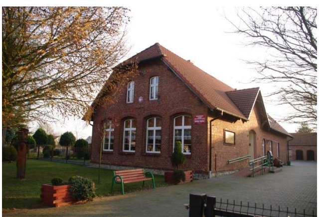
Przedszkole i świetlica wiejska w Barucie.
