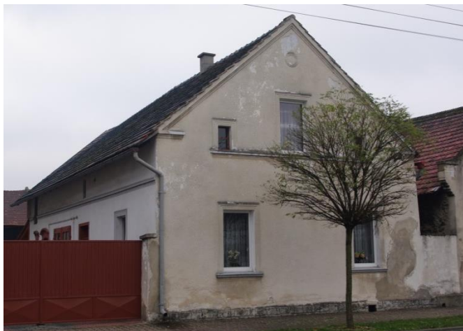
Jemielnica, ul. Wiejska nr 42
