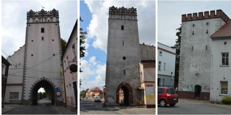
Fot. 20. Grodków. a) Wieża Bramy Lewińskiej, b) Wieża Bramy Ziębickiej, c) Baszta Więzienna (fot. materiały Gminy Grodków).
