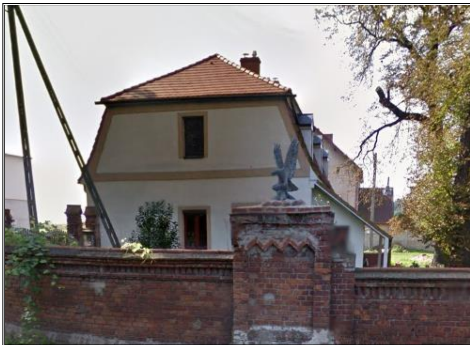
Rysunek 90. Budynek mieszkalny nr 8 w Woskowicach Małych
