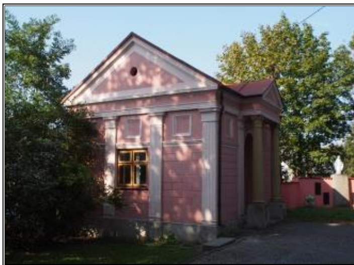
Rysunek 80. Mauzoleum, ob. kaplica przedpogrzebowa w Przeczowie
