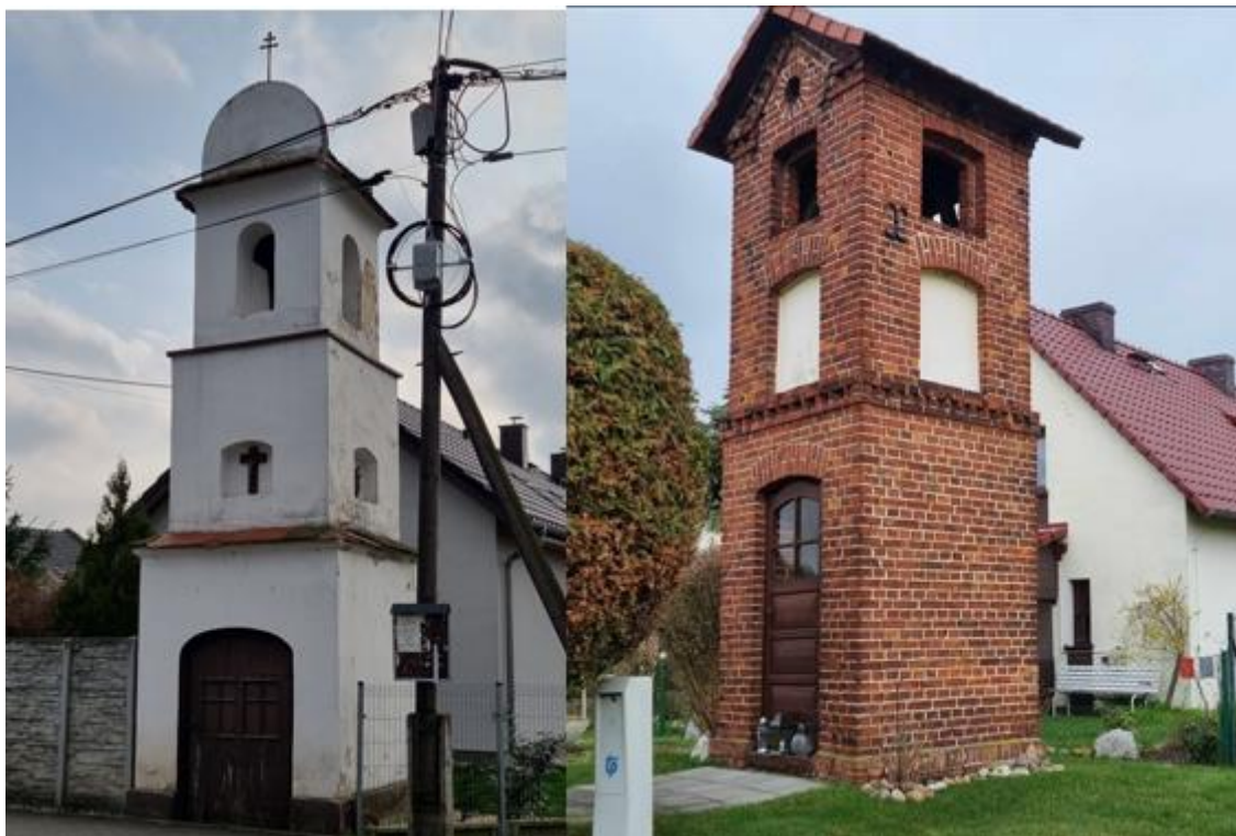
Fotografia 8. Kapliczki dzwonnice w Zawadzie (od lewej) i Turawie (od prawej).
