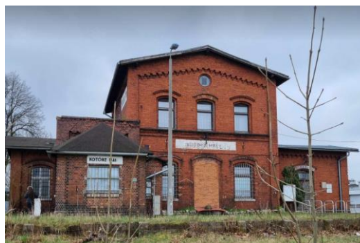
Fotografia 11. Widok na Budynek stacyjny PKP w Kotórze Małym.
