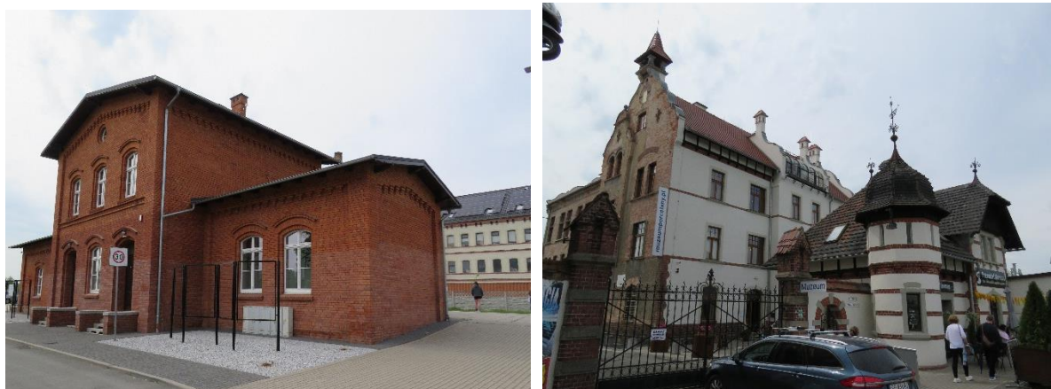
Ryc. 27 Budynek dawnego dworca kolejowego w Tułowicach, adaptowany na cele ekspozycji kolekcji porcelany tułowickiej Muzeum Ceramiki "TUŁOWICE poKolei", Ryc.28 Muzeum Porcelany Śląskiej na terenie dawnej fabryki porcelany
