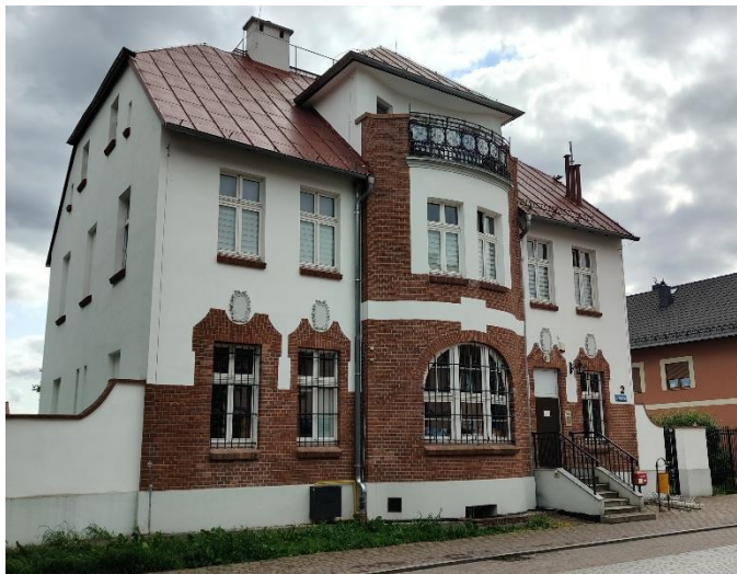
Ryc. 12 Budynek poczty z 1885 roku w Tułowicach
