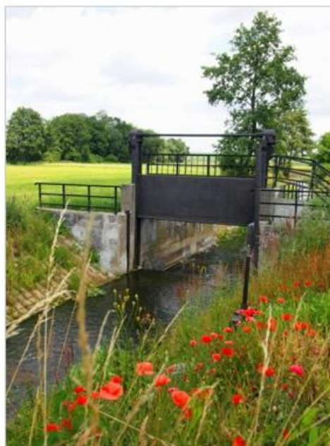
Jaz zastawkowy na Potoku Cisek (Jaborowice)
