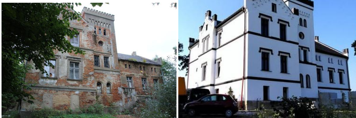
Dwór w Zurzycach przed- i po remoncie.
