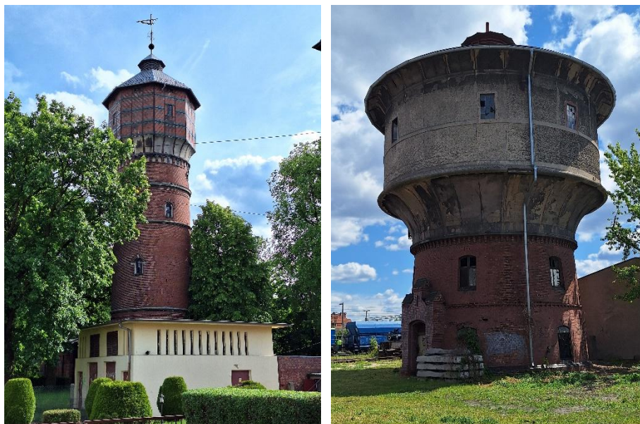
Ryc. 17. Wieża ciśnień w zespole wodociągów miejskich (po lewej), wieża ciśnień nr 3 przy ul. Towarowej) (po prawej)
