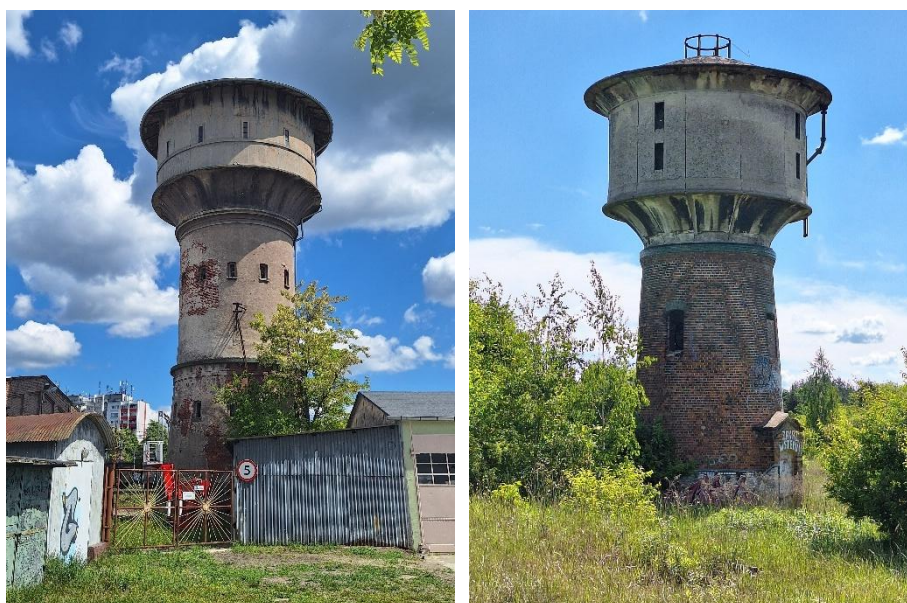
Ryc. 18. Wieża ciśnień nr 4 przy ul. Towarowej, kolejowa wieża ciśnień przy ul. Grzybowej
