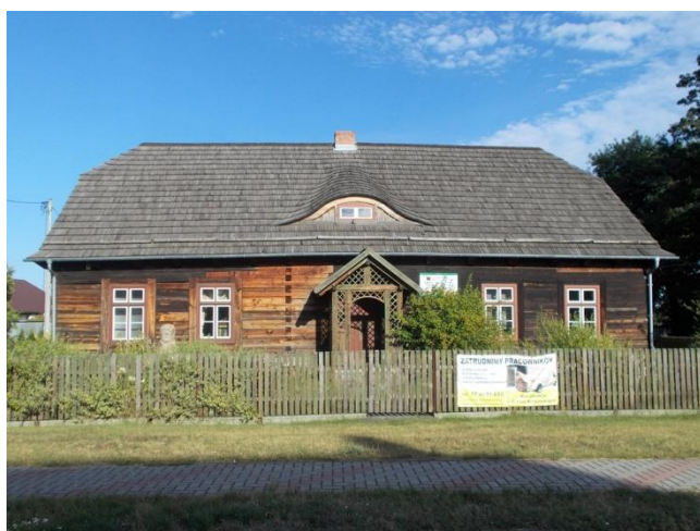
Widok zachodniej elewacji
