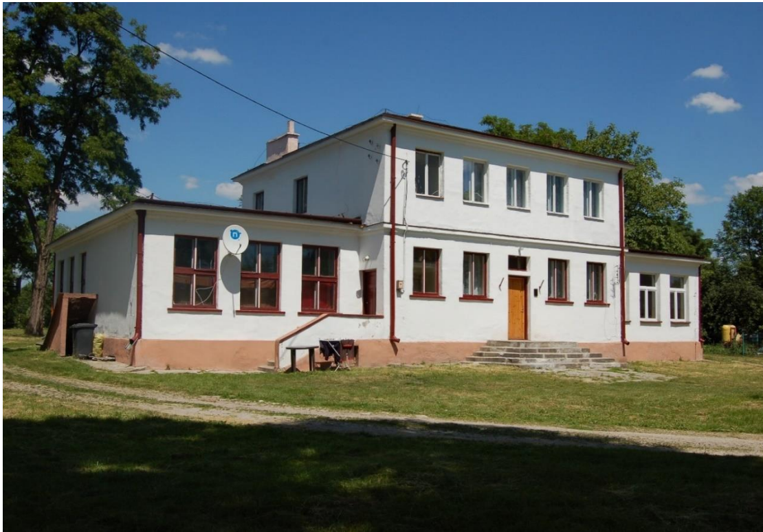
Fotografia 27 Budynek byłej szkoły w Gackach
