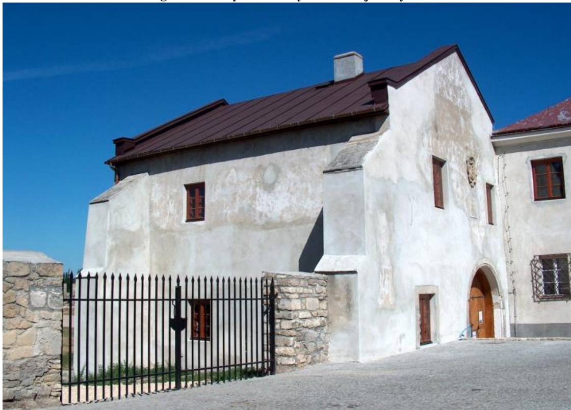
Fotografia 3 Budynek Bramy Zamkowej w Szydłowie
