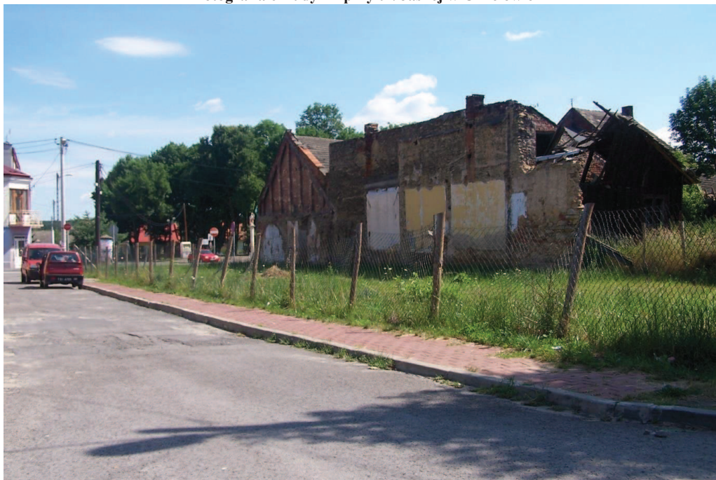
Fotografia 6 Budynki przy ul. Jasnej w Ćmielowie
