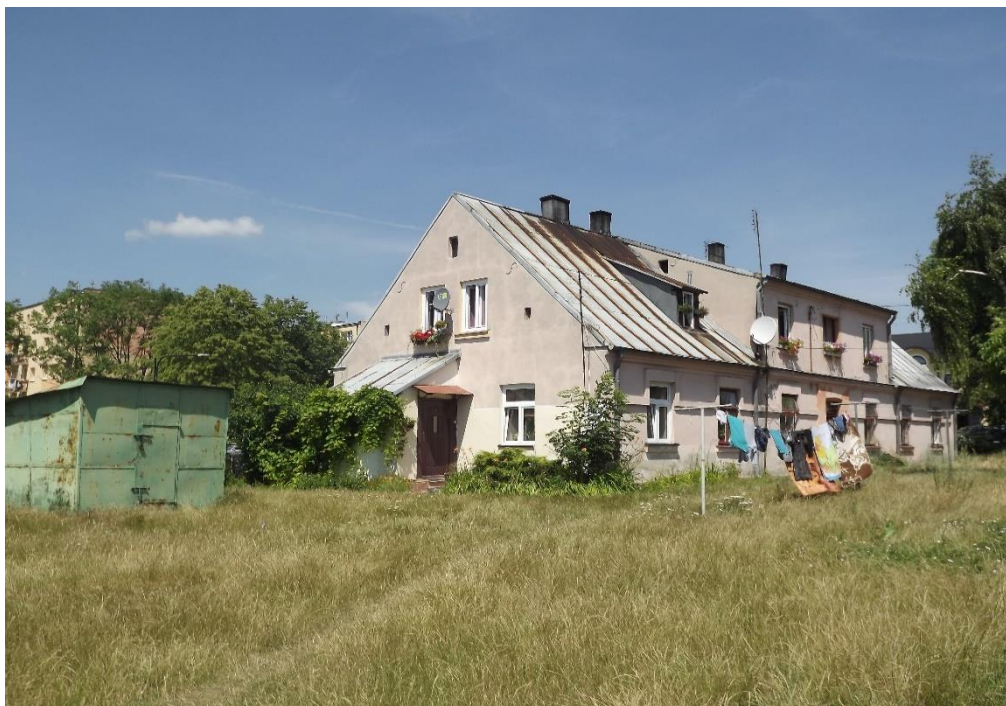
Fotografia 2 Budynek zasobów mieszkaniowych Gminy Busko-Zdrój przy ul. Bocznej
