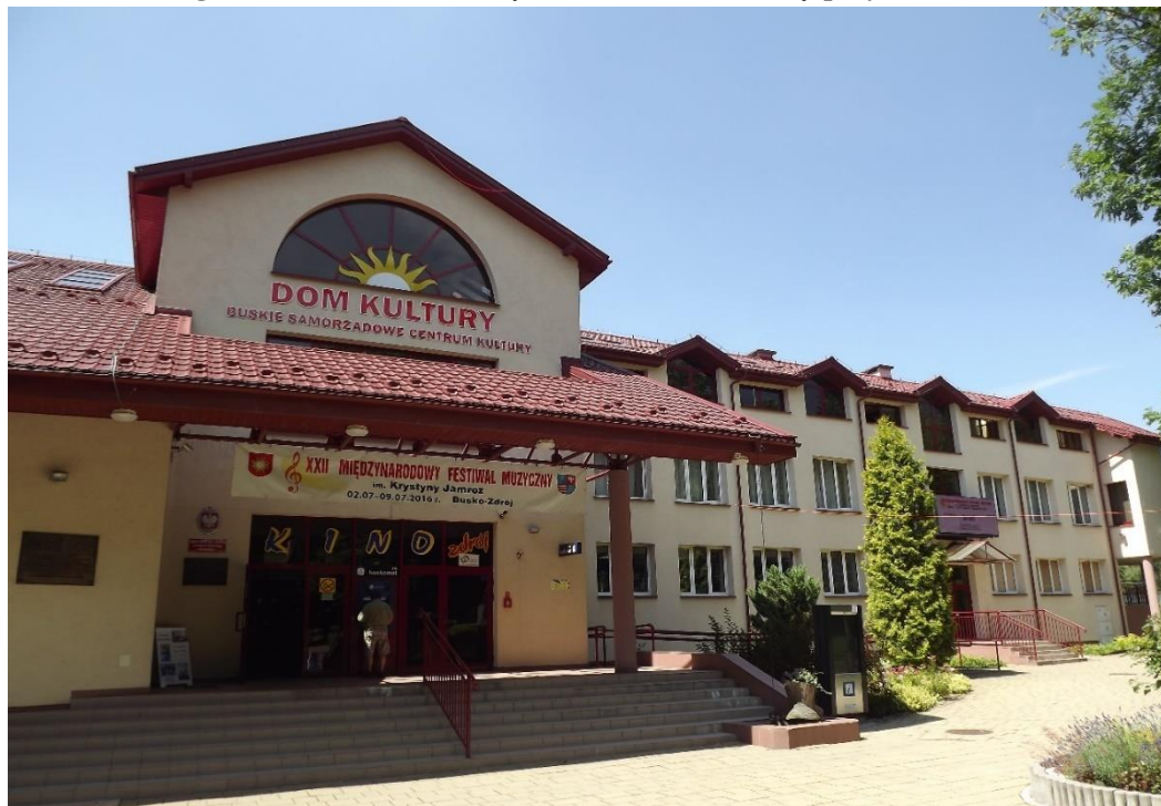
Fotografia 22 Buskie Samorządowe Centrum Kultury przy al. Mickiewicza
