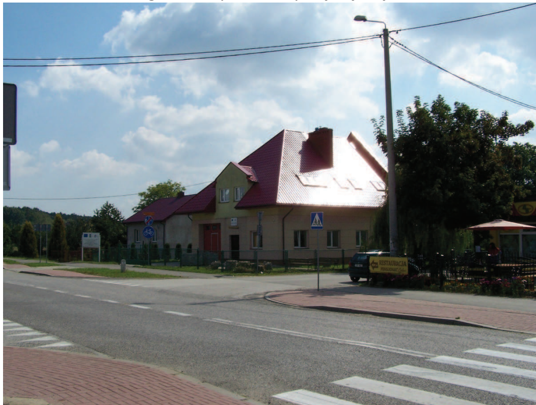
Fotografia 9 Budynek świetlicy wiejskiej w Ujeździe
