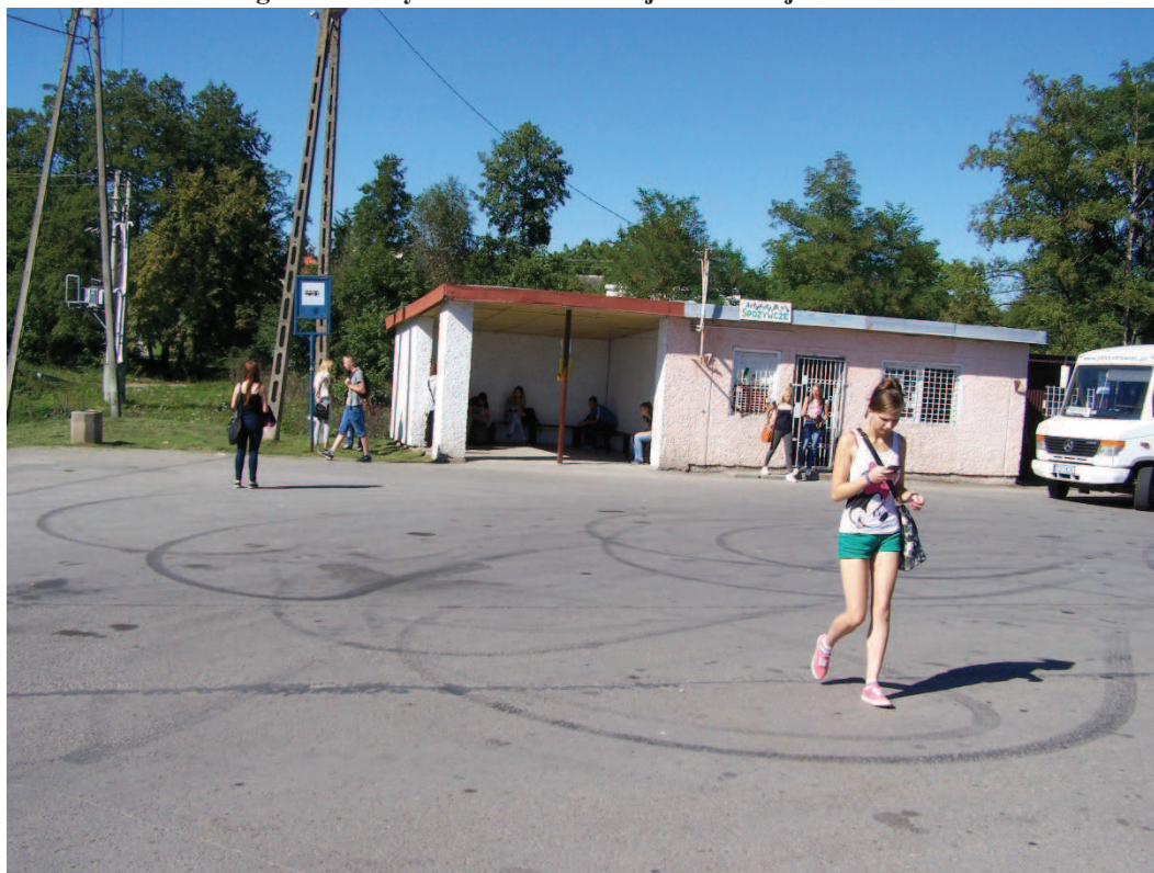
Fotografia 4 Przystanek komunikacji zbiorowej w Iwaniskach
