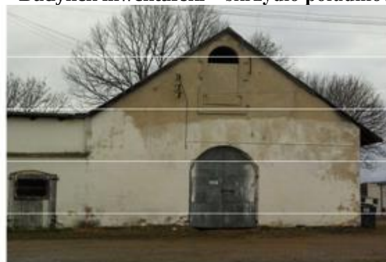
Budynek inwentarski – skrzydło północne
