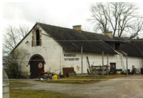
Budynek inwentarski – skrzydło południowe
