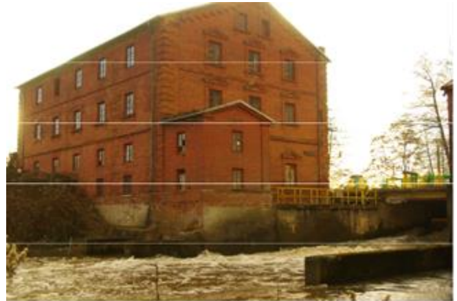
Młyn gospodarczy z widocznym budynkiem turbiny i korytem doprowadzającym wodę
