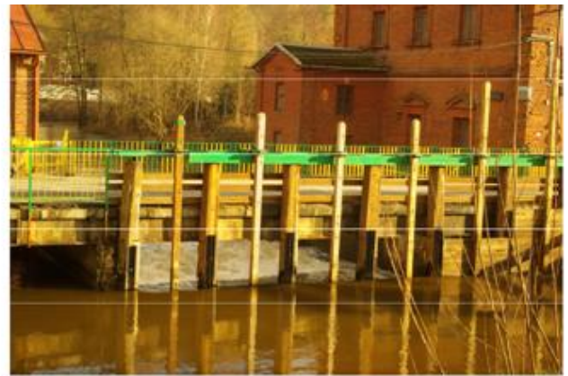
Jaz, po lewej kanał dopływowy do zachowującej sprawność elektrowni wodnej
