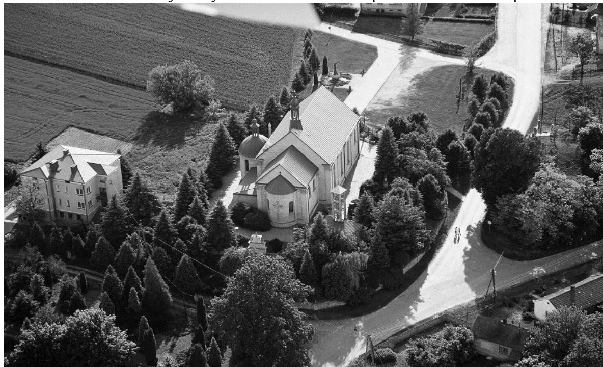
Kościół w Malicach Kościelnych w lotu ptaka
