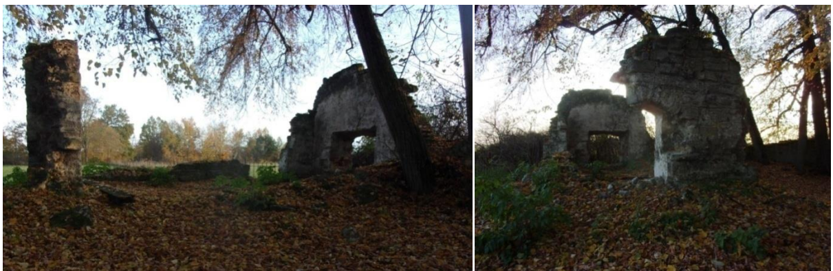
Pozostałości pawilonu parkowego (ogrodowego)
