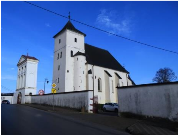
Widok na kościół od strony ul. Szpitalnej
