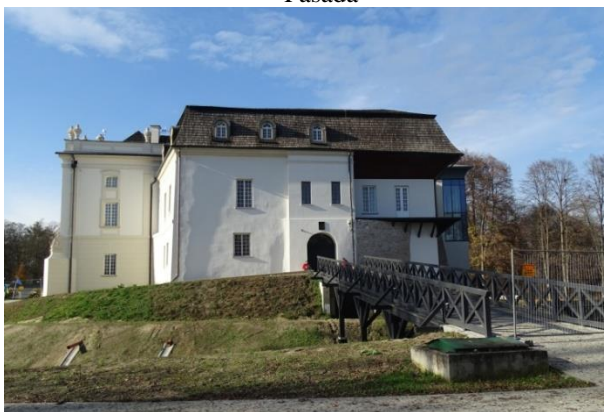
Widok na elewację wschodnią
