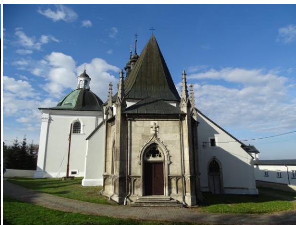
Widok na elewację wschodnią
