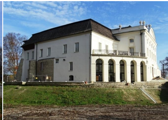
Widok na elewację zachodnią
