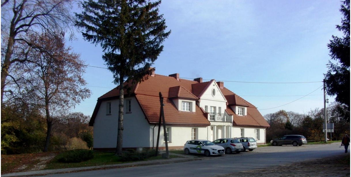
Budynek administracji, ob. Rzadzówka
