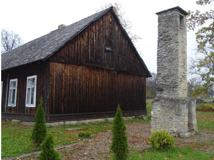
Latarnia leśna w Wiązownicy-Kolonii
