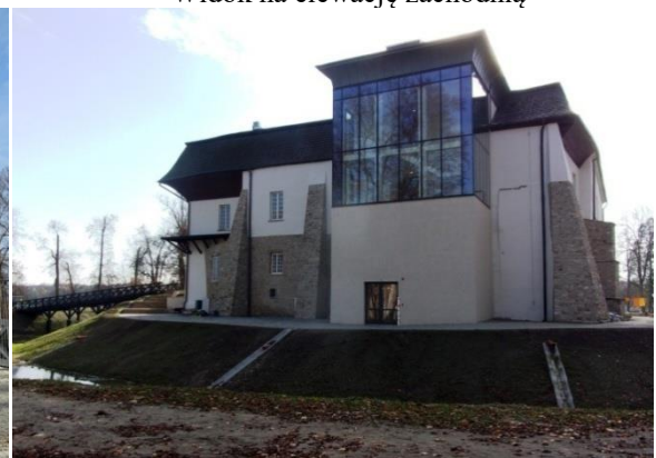
Widok na elewację tylną
