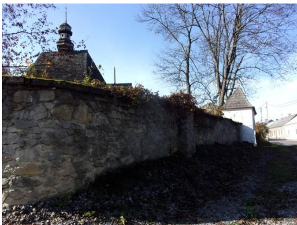
Ogrodzenie, widok od strony ul. Staszowskiej
