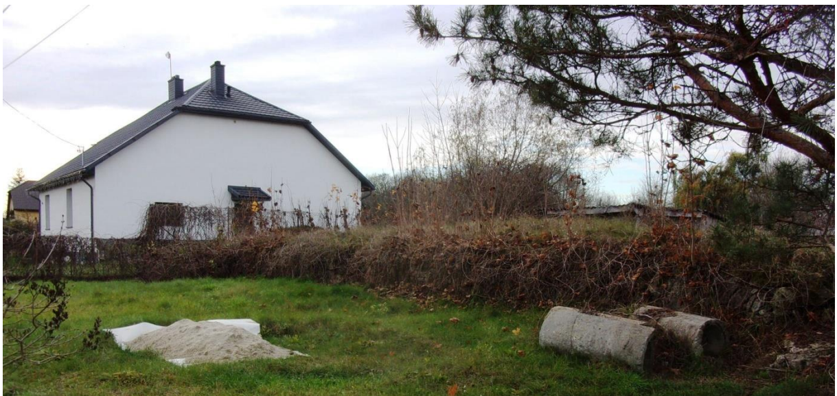
Ocalała część dworu i piwnice w Dobrej, ob. w Podmaleńcu
