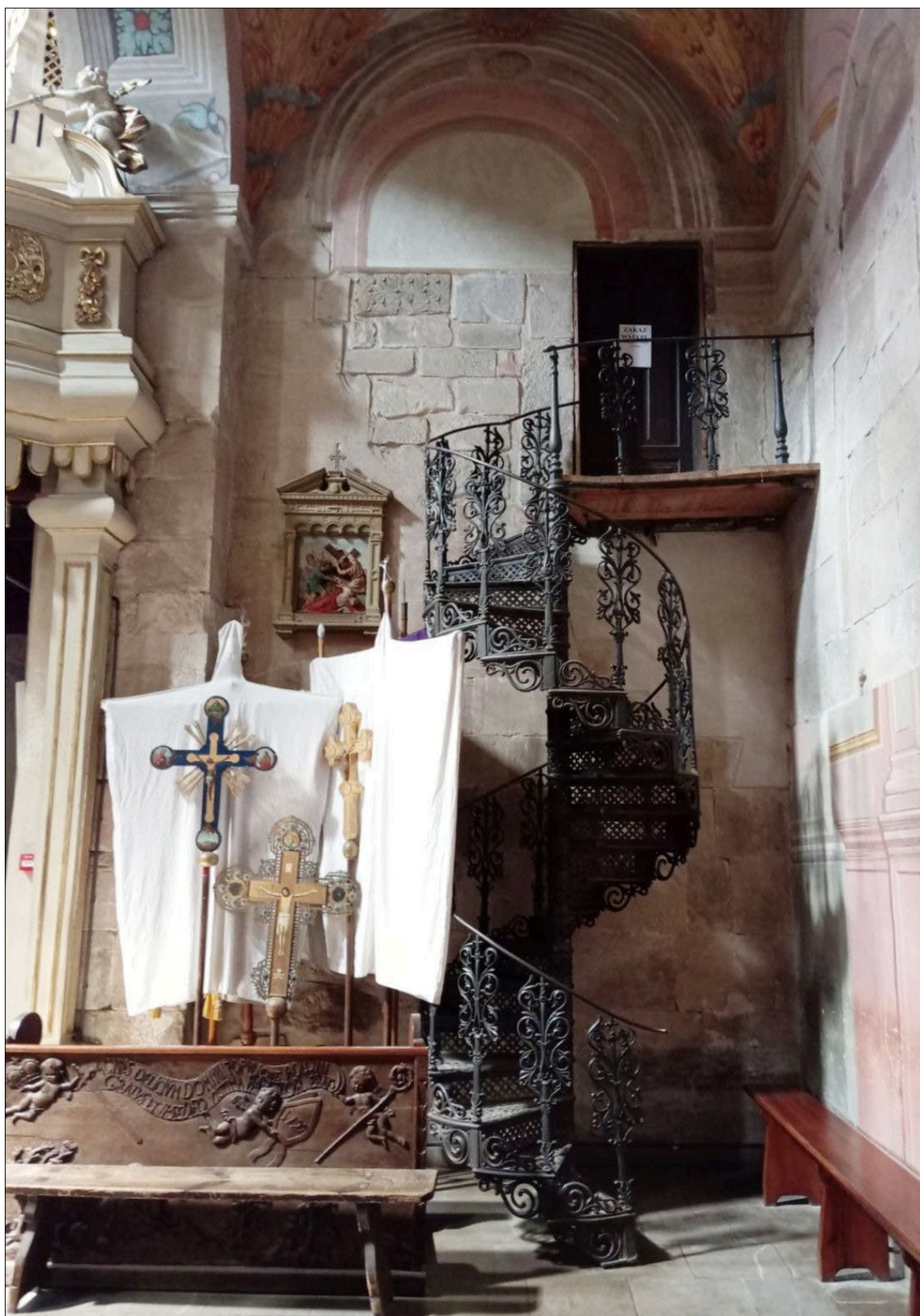
Ażurowe żeliwne kręte schodki, znajdujące się w narożniku północno-zachodnim, prowadzące na chór oraz północną wieżę, niezwykle interesująco prezentujące się na tle surowych ciosów. Obok schodków na ścianach nawy północnej widoczne są zamurowane wejścia,
