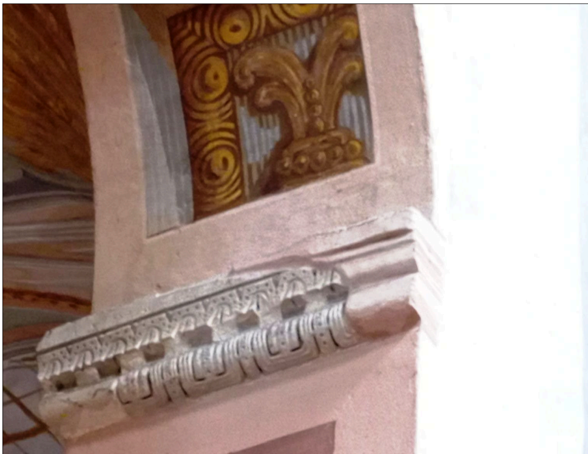
Fragmenty romańskich filarów międzynawowych z zachowanymi na nich częściowo wykutymi w kamieniu detalami zdobniczymi (te od strony nawy głównej zostały skute pod malowidła; fot. 2024 r.
