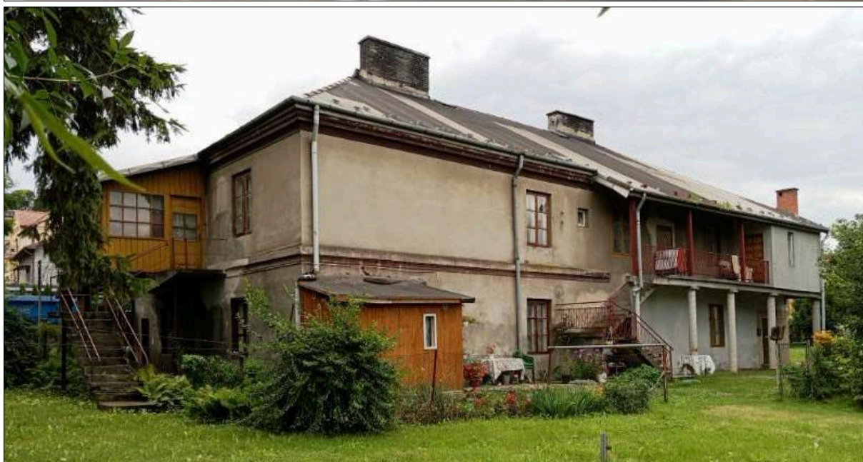
Dawny urząd powiatowy w Opatowie, przy ul. Jana Kilińskiego 4; fot. 2024 r.
