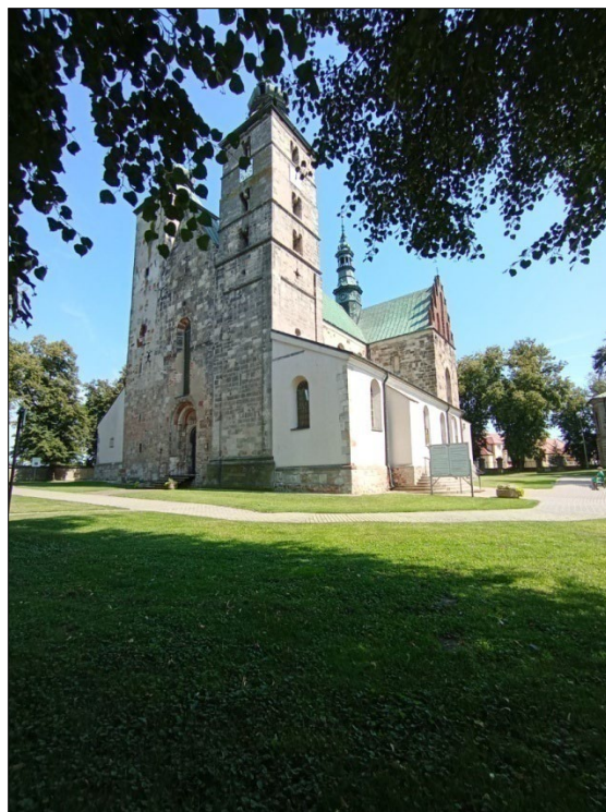
Widok na kolegiatę od strony południowo-zachodniej; fot. 2024 r.
