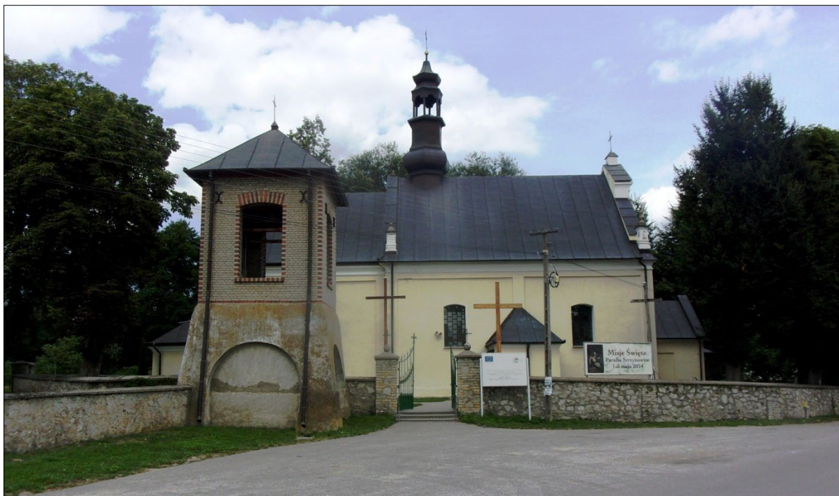
Widok na zespół kościelny od strony południowej; fot. 2024 r.
