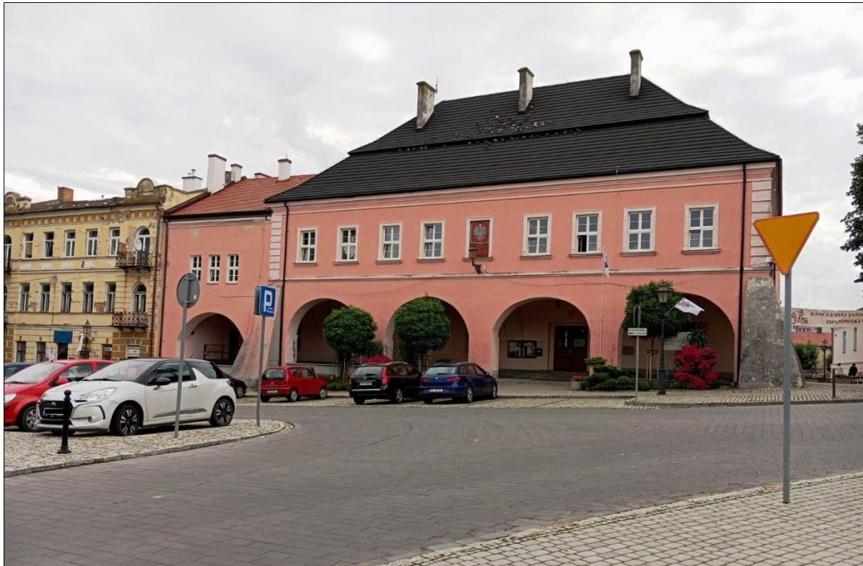
Dom z podcieniami – widok na fasadę, fot. 2024 r.
