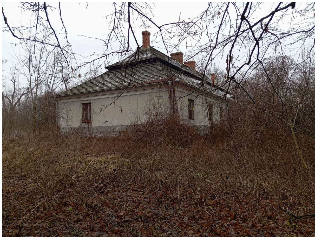
Park podworski w Nikiszałce Małej z fragmentem dworu; fot. 2024 r.
