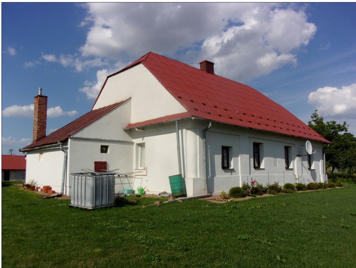
Plebania – elewacja tylna – południowa i szczytowa – zachodnia; fot. 2024 r.
