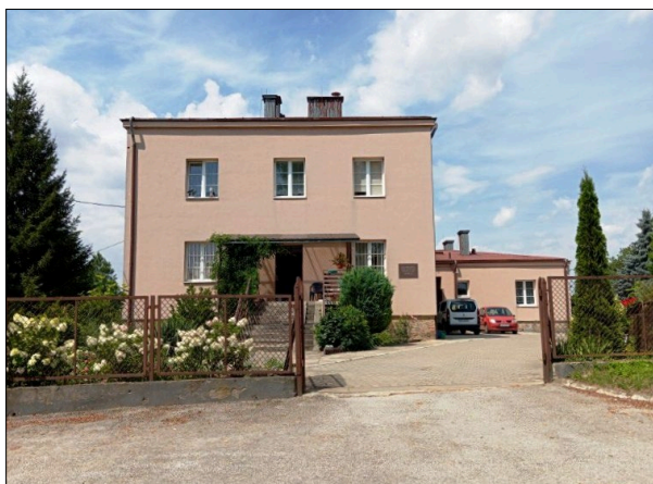
Budynek mieszkalny sióstr w Lipowej z kaplicą; fot. 2024 r.
