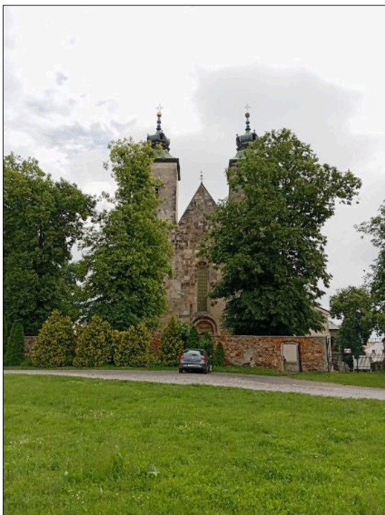
Widok na fasadę od zachodu; fot. 2024 r.
