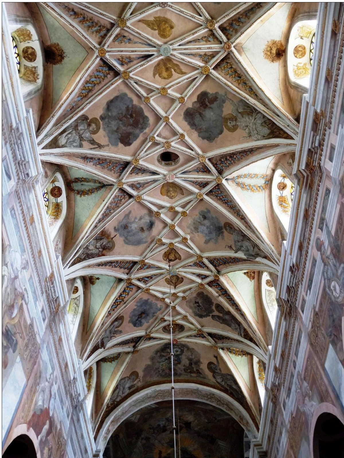
Sklepienie nawy głównej; fot. 2024 r.
