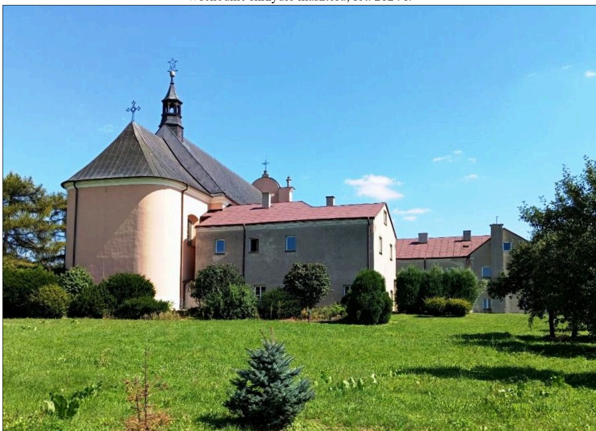
Elewacja tylna kościoła i zachodnie skrzydło klasztoru; fot. 2024 r.
