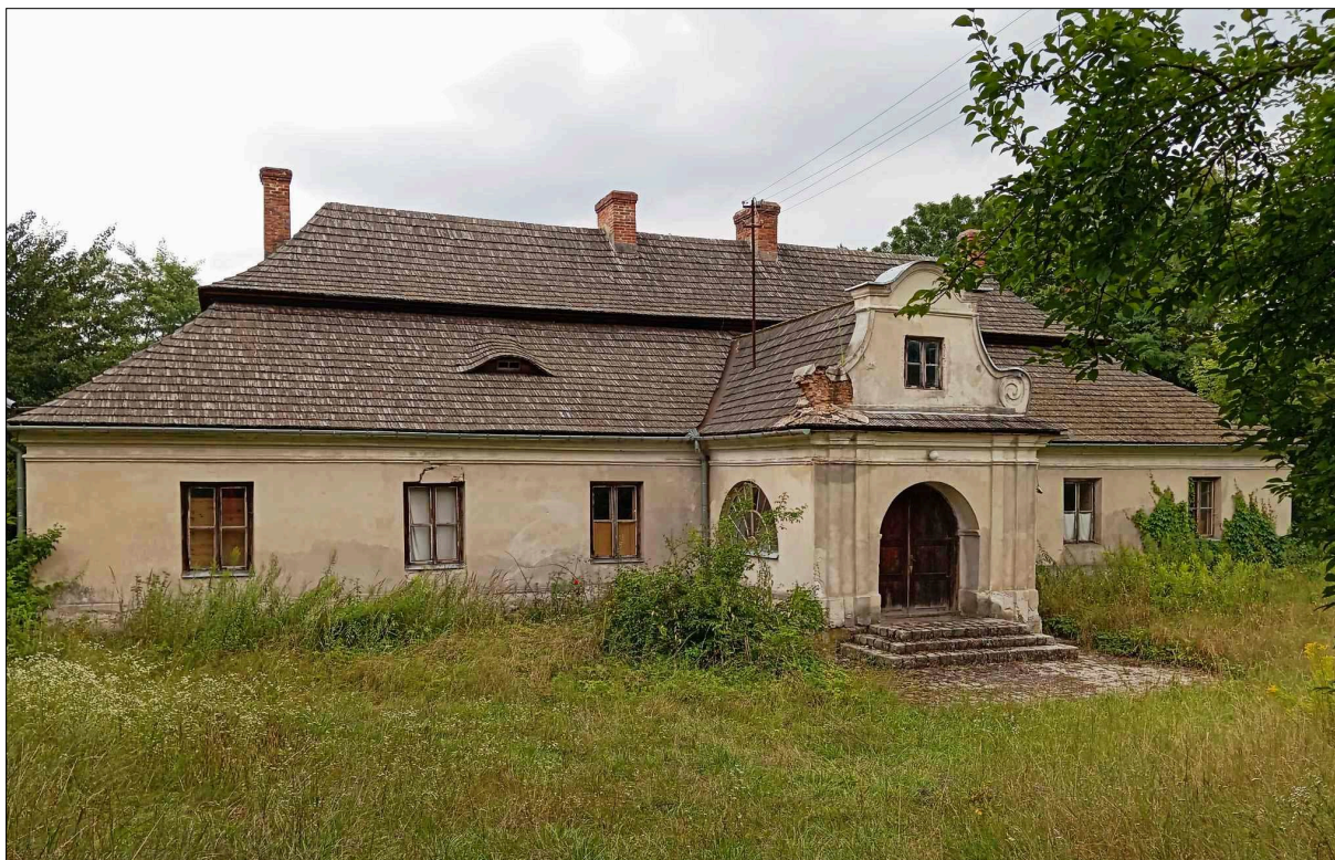
Dwór w Nikiszałce Małej – widok na fasadę; fot. 2024 r.
