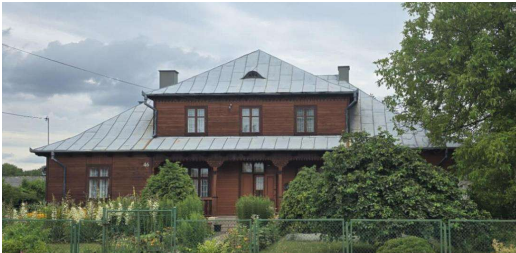
Fotografia 13. Widok na budynek plebani w zespole kościoła pw. Św. Andrzeja Zespół kościoła pw. śś. Piotra i Pawła w Piotrowicach – Zarzeczcu
