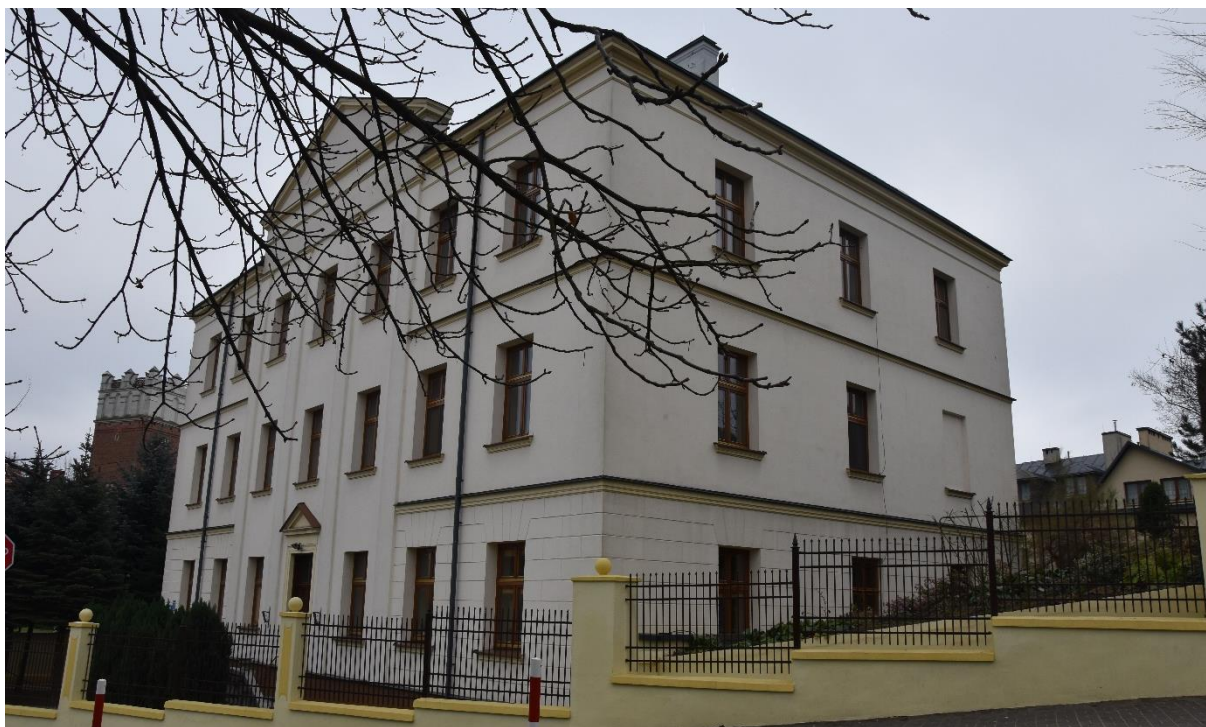
Fot. 19. Dom Zgromadzenia Sióstr Służek NMP (źródło: Gminna Ewidencja Zabytków).
