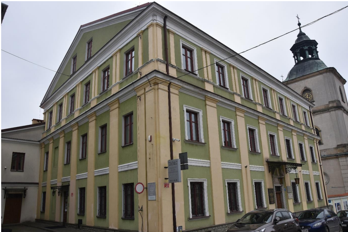
Fot. 15. Dawny Dom Księża Emerytów (źródło: Gminna Ewidencja Zabytków).
