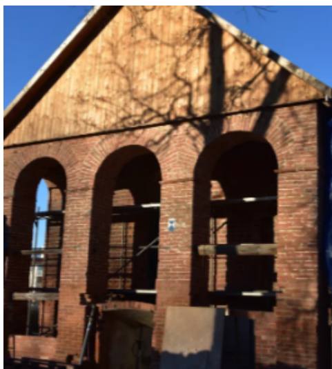
Murowaniec w zespole dworskim w trakcie prac remontowych
