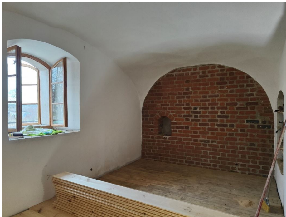
Budynek Murowańca w trakcie robót budowlanych wewnątrz obiektu
