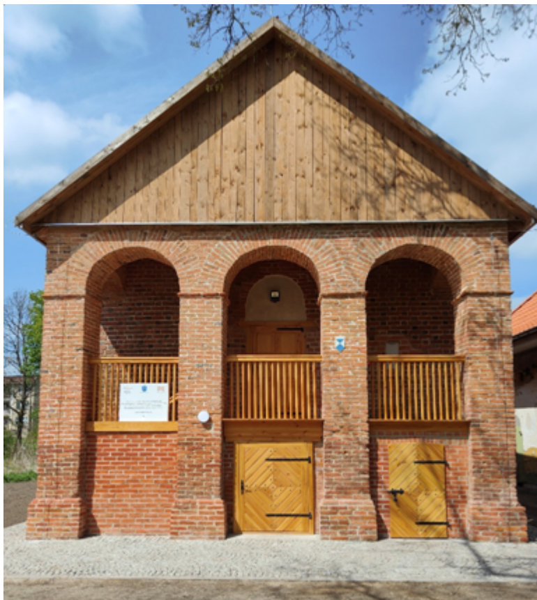
Zrewaloryzowany budynek Murowańca – czerwiec 2024
