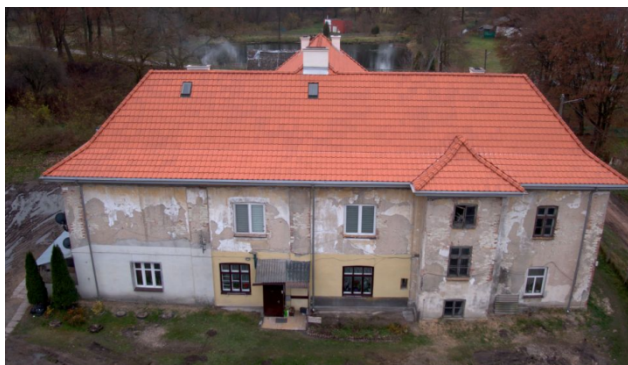
Oficyna w zespole dworskim po wymianie dachu
