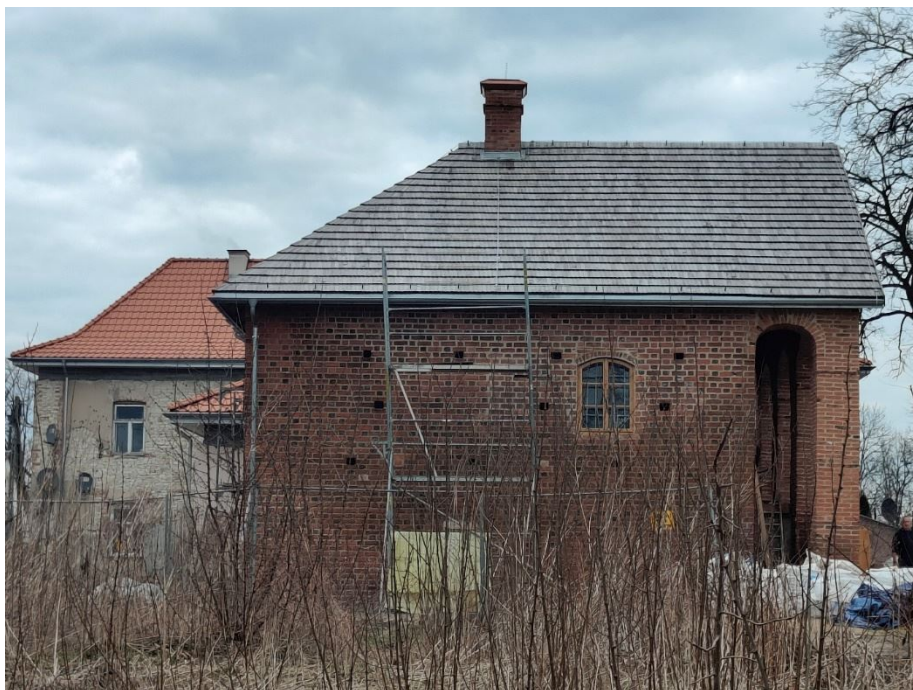
Budynek Murowańca w trakcie robót budowlanych
