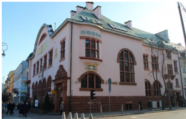
Fotografia 6. Widok na Dawny budynek towarzystwa wzajemnego kredytu (ul. H. Sienkiewicza 47).
