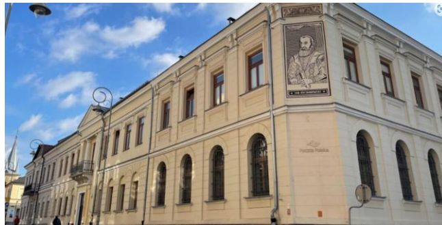
Fotografia 1. Widok na budynek poczty (ul. H. Sienkiewicza 7).
