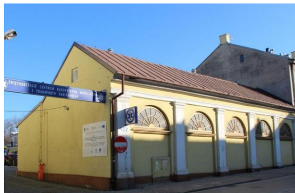
Fotografia 7. Widok na Budynek straży pożarnej (ul. Leonarda 10).
