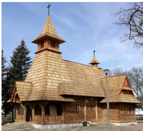
Fotografia 14. Widok na Kościół parafialny pw. Przemienienia Pańskiego w Kielcach.
