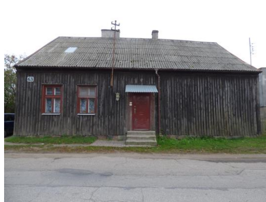
Fot. 20. Budynek szkoły Źródło: zdjęcie własne
