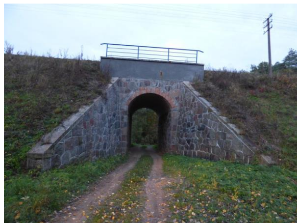
Fot. 14. Wiadukt kolejowy Źródło: zdjęcie własne
