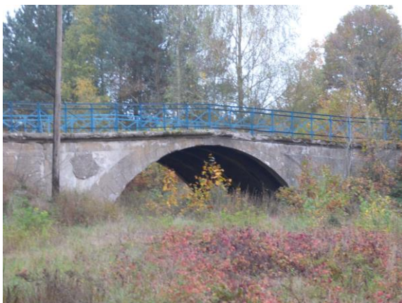
Fot. 13. Most drogowy Źródło: zdjęcie własne
