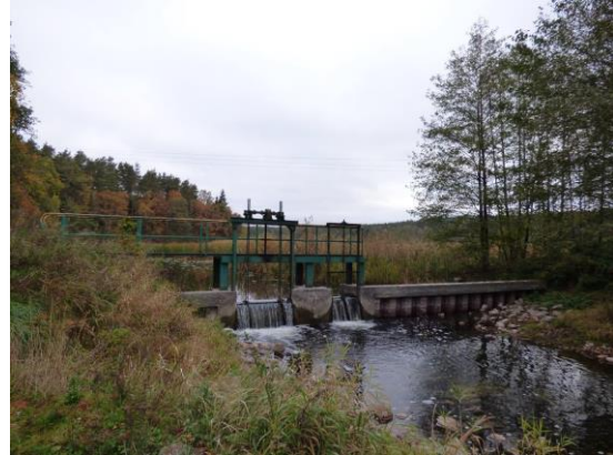
Fot. 24. Przepust wodny
