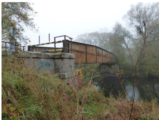
Fot. 19. Most blachownicowy Źródło: zdjęcie własne
