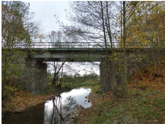
Fot. 23. Most kolejowy
