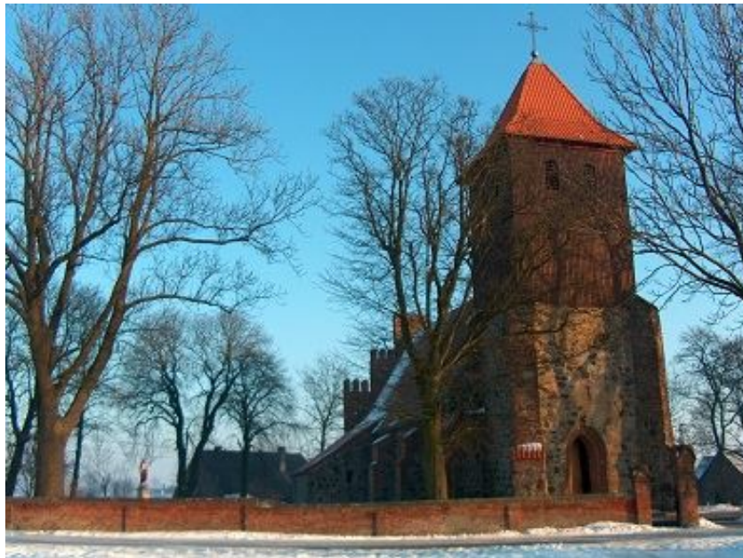
Kościół pw. św. Michała Archanioła w Grzybnie
