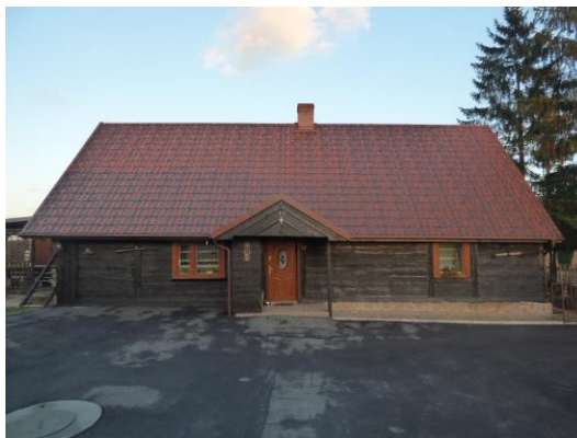
Fot. 4. Budynek mieszkalny drewniany w Trzeciewcu z pocz. XIX w.
