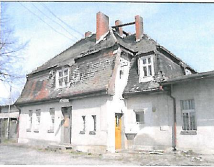
128. Żalno, dworzec, ul. Kolejowa nr 4
