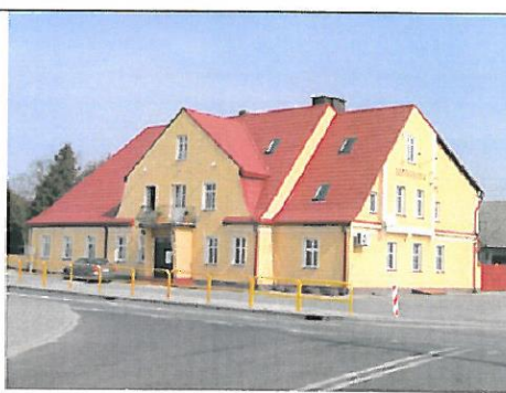
124. Żalno, zajazd, ul. Chojnicka nr 2
