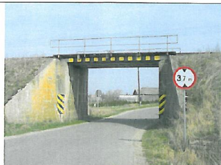
138. Żalno, wiadukt kolejowy – linia kolejowa nr 208
