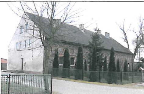
31. Kęsowo, zespół dworski, budynek inwentarski, ul. Wyzwolenia nr 1
