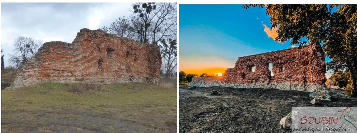
Fot. 21. Ruiny zamku starościńskiego w Szubinie przed (2016 r.) i po wykonanych pracach konserwacyjnych (2022 r.)
