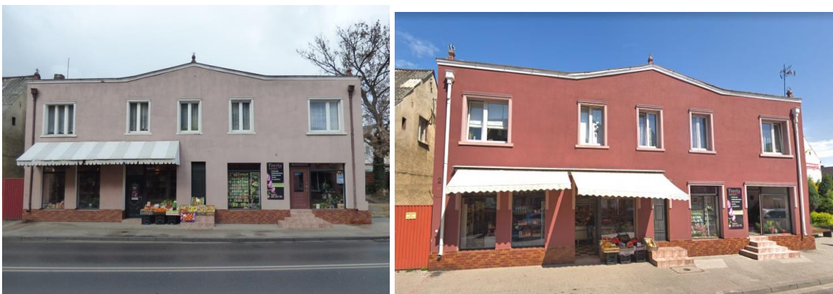
Fot. 7. Budynek mieszkalno-usługowy przy ul. 3 maja 2 przed (2016) i po remoncie (2018)
