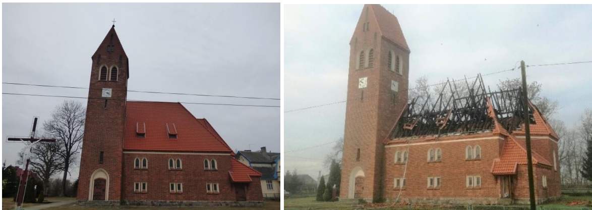
Fot. 9. Kościół w Ciężkowie przed (2016) i po pożarze dachu (2018)
