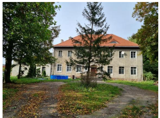
Fotografia 10. Widok na pałac w Marulewach.
