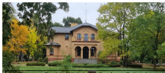
Fotografia 11. Widok na Dwór w Orłowie.
