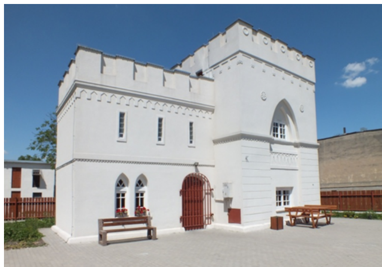
Fot. 10. Pawilon, tzw. szubienica w Kamiennej
