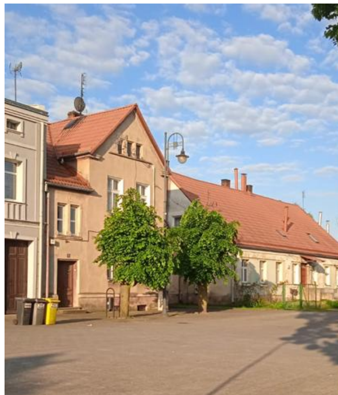
Budynek pastorałki wraz z budynkiem, w której funkcjonowała salka (obiekty niegdyś należące do kościoła ewangelickiego)
