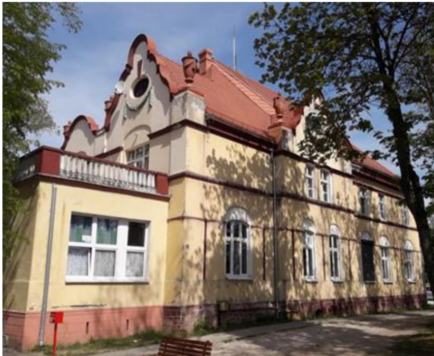
Obiekt budynku przy ul. 11 Listopada 3 w Piechcinie
