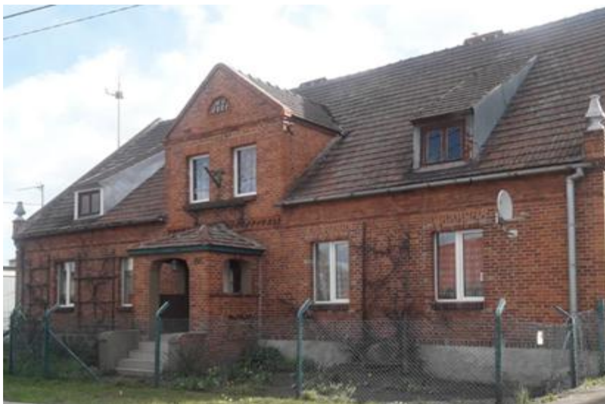
Budynek mieszkalny w Krotoszynie
