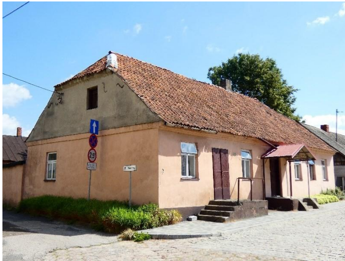
Fot. 15. Dom w Raciążku przy ul. Zamkowej 39
