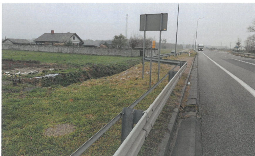
Fot.2. DK10 km 374+570 kierunek Warszawa
