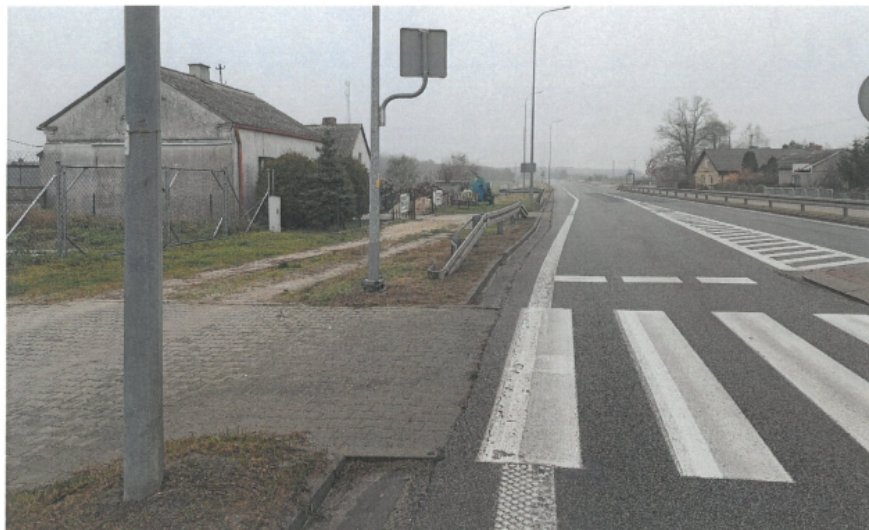
Fot.1. DK10 km 374+529 kierunek Warszawa
