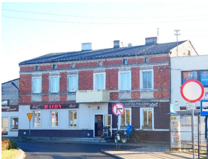
Fot. 10. Dom, ob. budynek mieszkalno-usługowy w Łochowie
