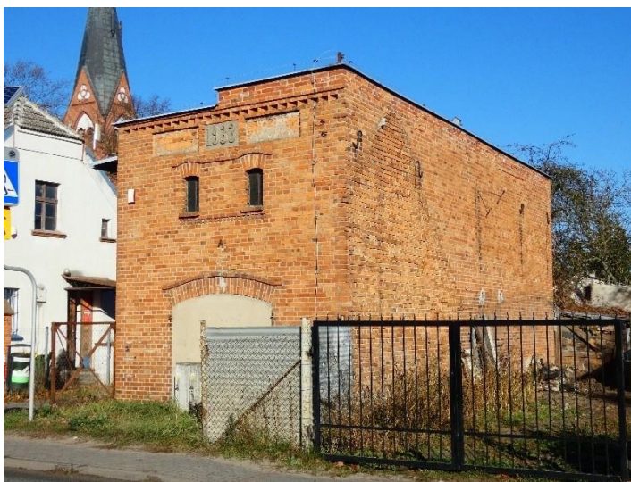
Fot. 11. Budynek gospodarczy przy poczcie w Łochowie
