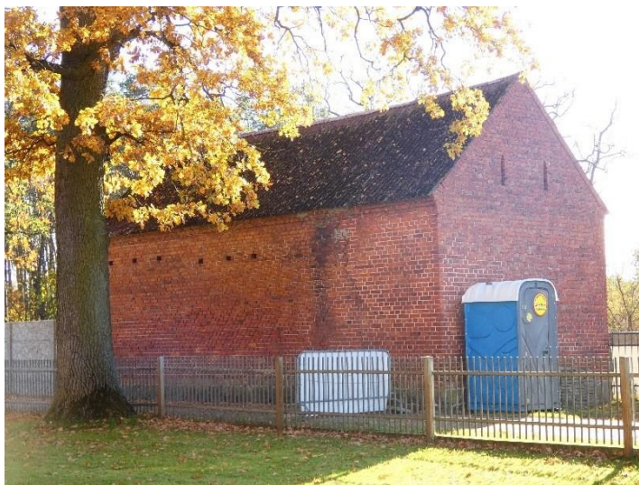
Fot. 17. Budynek gospodarczy nr 2 w zespole kościoła w Cielu
